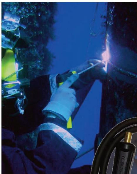
El Hydroweld **EH400** es una pinza o lanza de soldadura submarina, utilizada por toda la industria. Estas económicas pinzas ligeras pero resistentes se distribuyen junto con un cable de aproximadamente 2 metros de 50 mm<sup>2</sup> acabado en un conector macho tipo Dinze.
